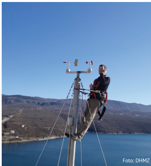
Servis automatske postaje na Krčkom mostu
